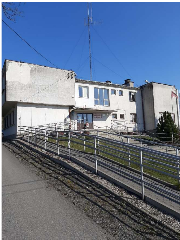
Zdj. 2 Stan przed termomodernizacją
