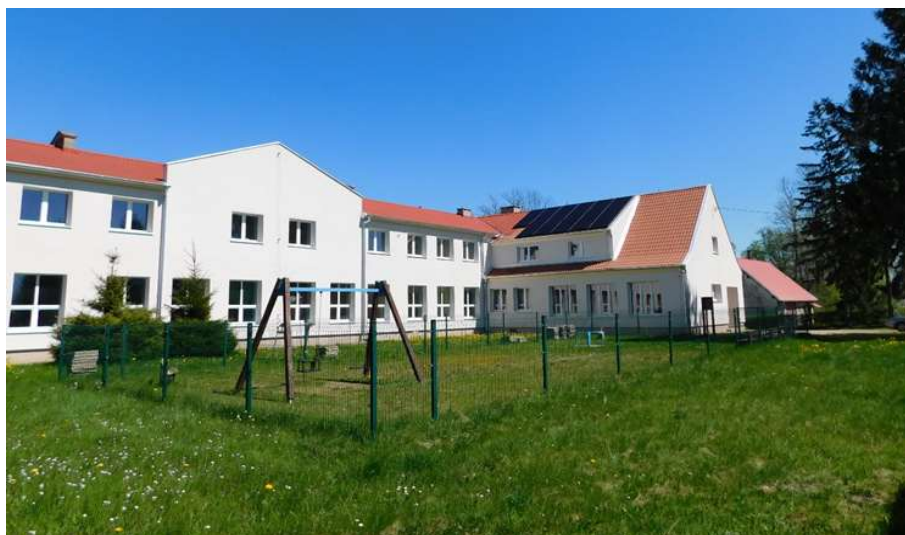
Zdj. 7 Pomorska Wieś 40 po termomodernizacji
