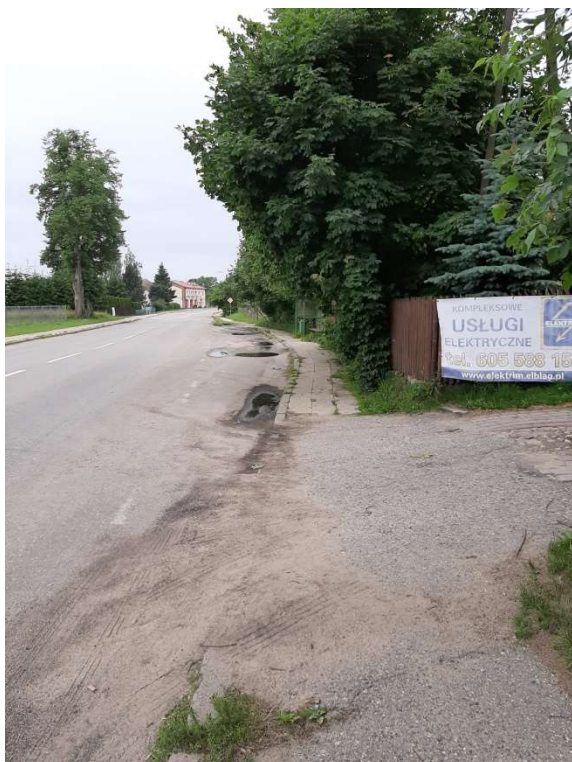
Zdj. 32 Ul. Elbląska przed przebudową
