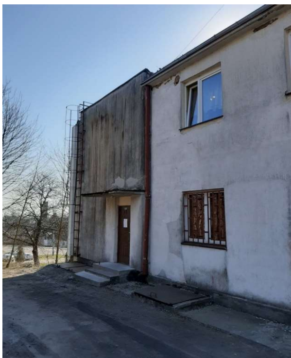
Zdj. 4 Stan przed termomodernizacją
