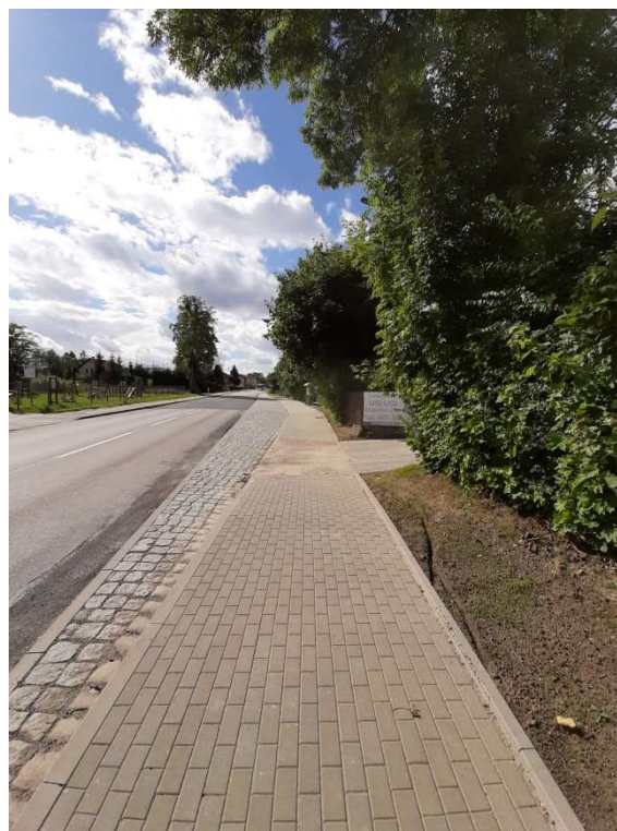
Zdj. 33 Ul. Elbląska po przebudowie
