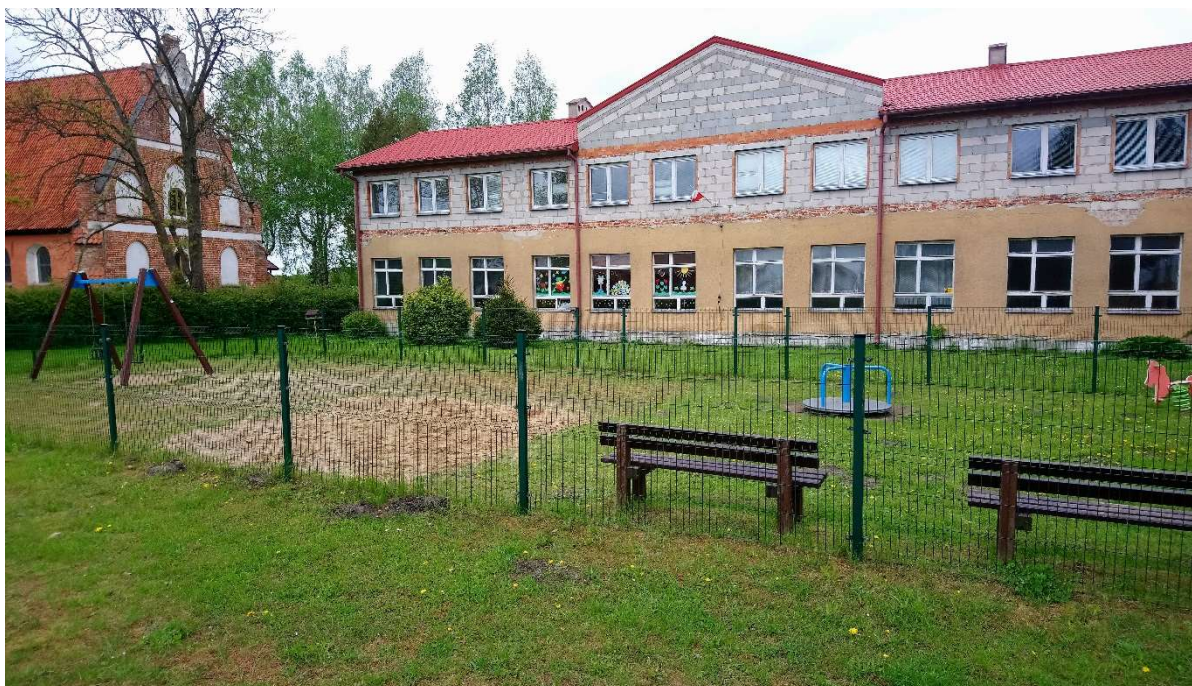
Zdj. 10 Pomorska Wieś 40 przed termomodernizacją
