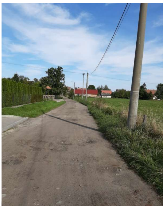
Zdj. 18 Ul. Stawowa przed modernizacją
