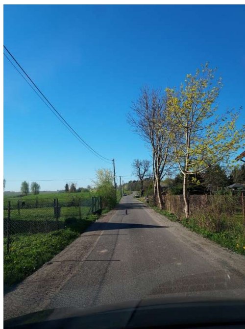
Zdj. 19 Ul. Stawowa po modernizacji
