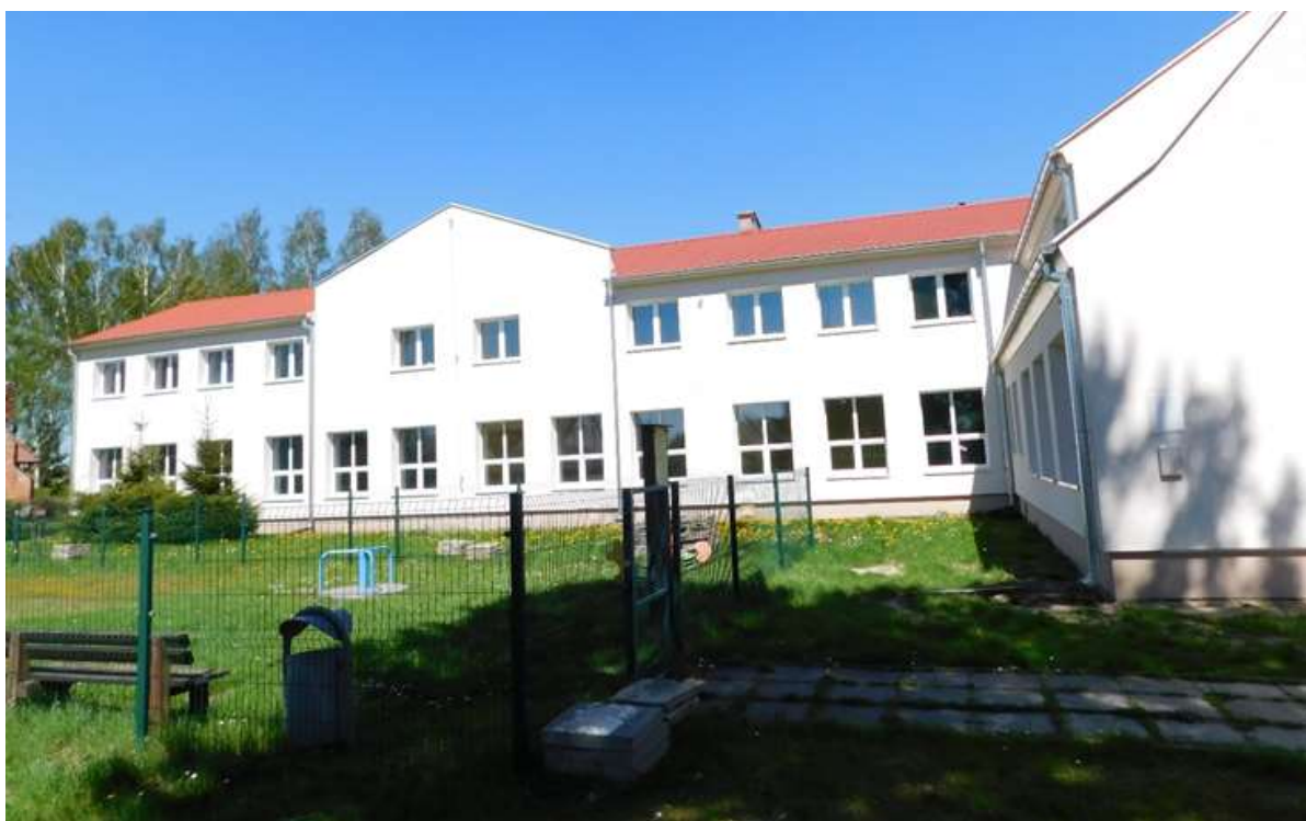
Zdj. 11 Pomorska Wieś 40 po termomodernizacji
