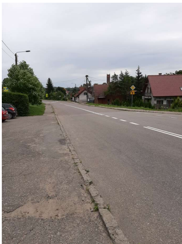
Zdj. 34 Ul. Elbląska przed przebudową
