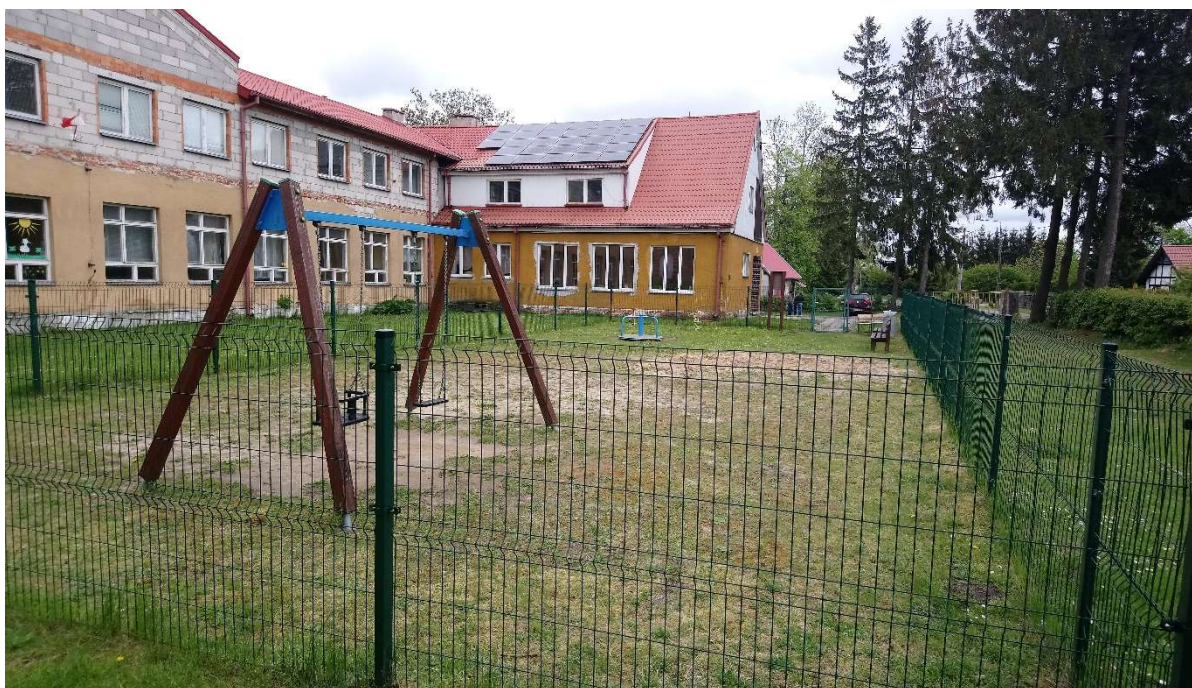
Zdj. 6 Pomorska 40 przed termomodernizacją
