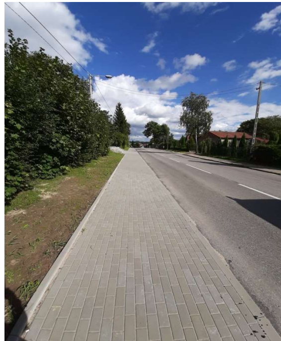
Zdj. 31 Ul. Elbląska po przebudowie
