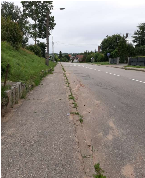
Zdj. 30 Ul. Elbląska przed przebudową
