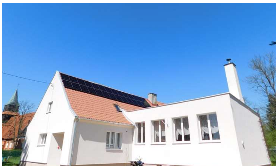
Zdj. 9 Pomorska Wieś 40 po termomodernizacji
