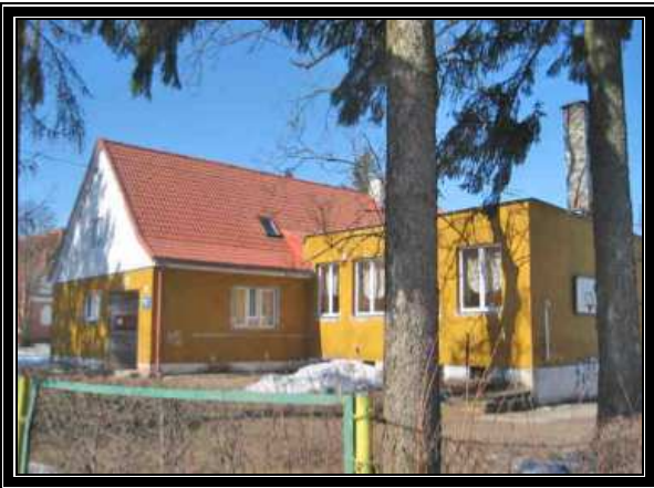
Szkoła z XIX/XX w., przebudowana
